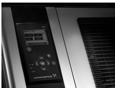
Рис. 32 Панель управления Grundfos CUE
